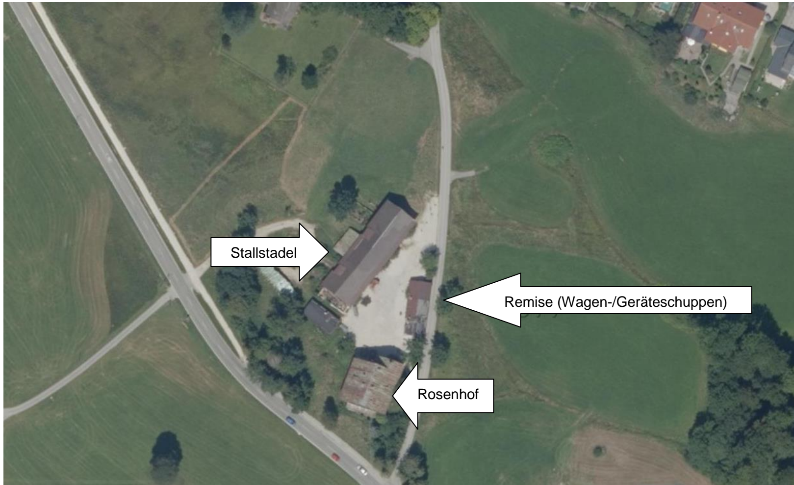
Abbildung 1: Ansicht des Gebäudeensembles
