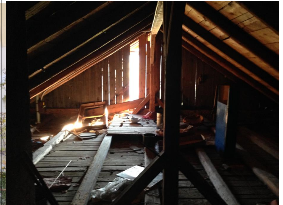
Abbildung 10: Rosenhof/ Innenansicht Dachstuhl
