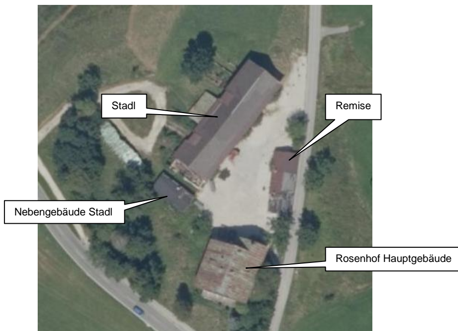
Abb. 1: Übersicht untersuchter Gebäude.
