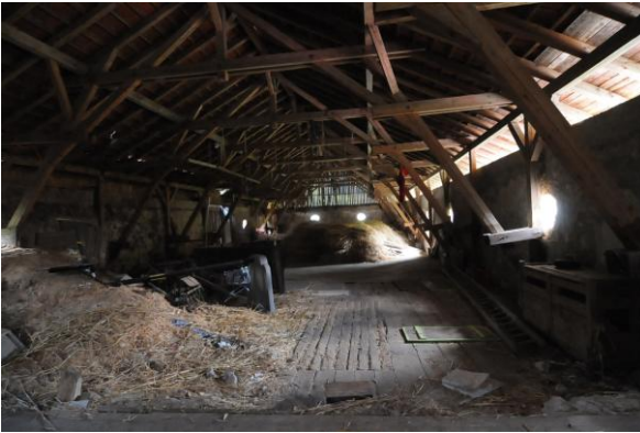
Abb. 16: Der Hintere raum wurde möglicherweise zur Taubenzucht genutzt. Die Kartonabdeckung wurde ebenfalls überprüft.
