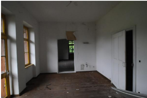
Abb. 2: Die Innenräume des Gebäudes sind für Fledermäuse zugänglich. Es gab keine Hinweise auf Hangplätze bzw. Fledermauskot.
